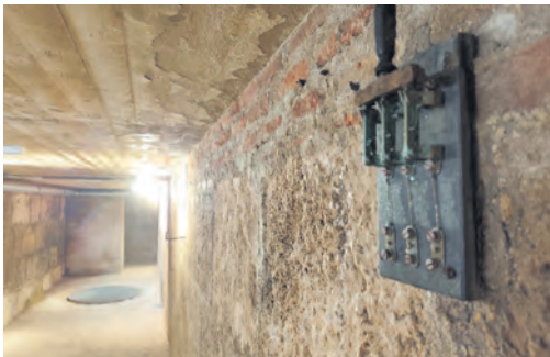
Finalizados los trabajos de rehabilitación del refugio antiaéreo de la Plaza de Cervantes
